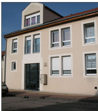
Bâtisse ancienne réaménagée en habitat collectif rue du Moulin
