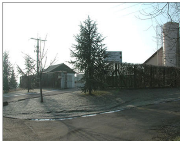
Station d'épuration chemin rural au Sud-Ouest du village
