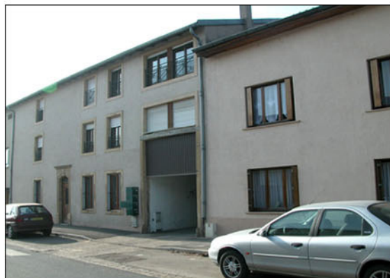
Bâtisse ancienne réaménagée en habitat collectif rue de Thionville
