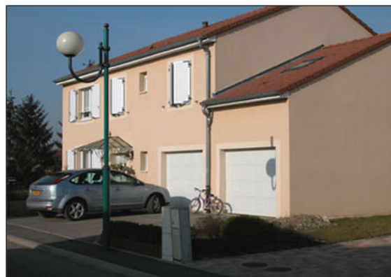
Pavillon des années 2000 rue des Saules
