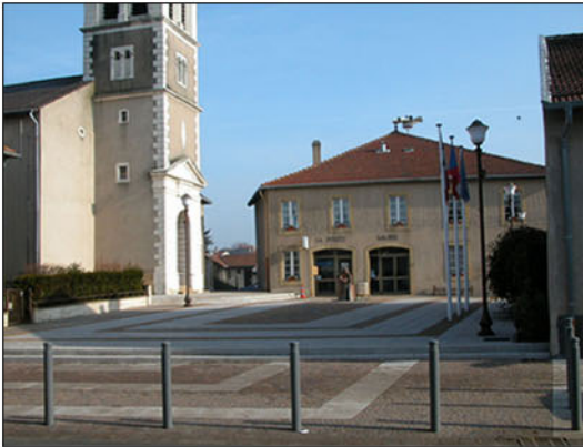
Espace public aménagé place de la Mairie
