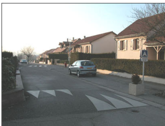
Traitement sécuritaire de la voirie rue de la Tournaille
