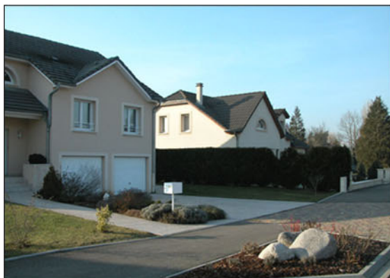
Pavillon des années 2000 rue de Thionville
