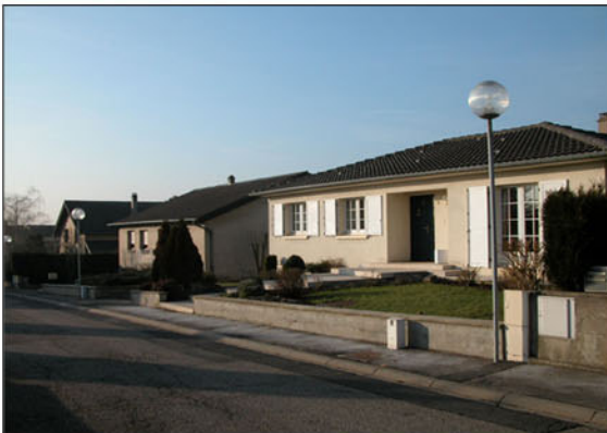
Pavillon des années 90 rue Charles Pelte
