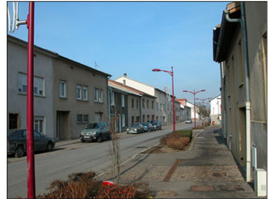
Anciens usoirs aménagés rue de Thionville
