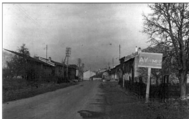
Entrée du village, au milieu du XXe siècle actuellement rue de Metz
