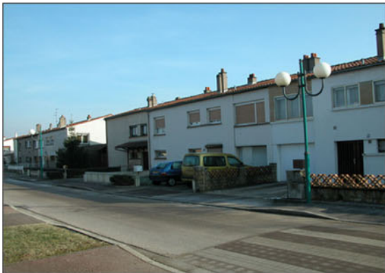
Maisons jointives des années 70 rue du Moulin
