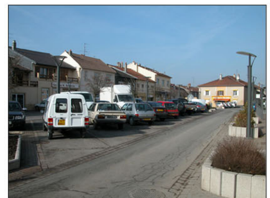
Réaménagement de la voirie et création d'aires de stationnement rue de Metz
